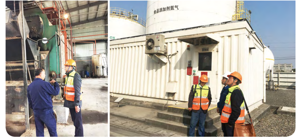
· 前往某化工企业现场开展安全生产隐患排查
