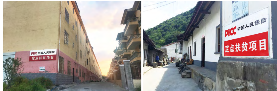
·乐安县南村乡稠溪移民新村基础设施建设项目
