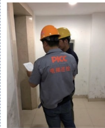
浙江杭州市分公司電梯巡檢人員對電梯進行日常安全巡檢
