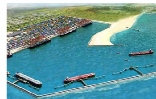
尼日利亚莱基港项目远景图
